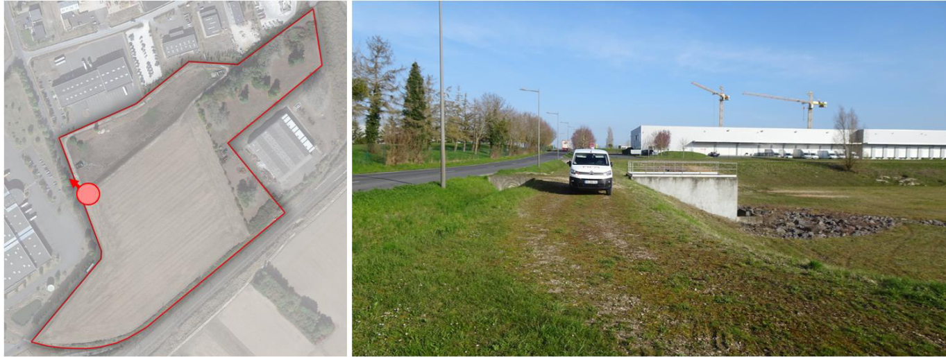
Figure 193 : Photographie de l'accès permettant de se rendre près du bassin de rétention puis dans le champ cultivé
