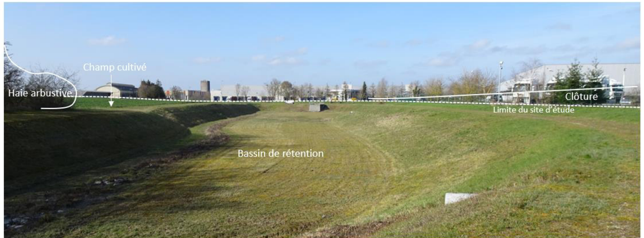
Figure 190 : Photographie de la limite nord du bassin de rétention appartenant au site d'étude (Crédit photo : NCA Environnement)
